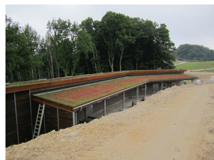
Figur 29: Sedumtag, Ree dyrepark. Foto Orbicon
